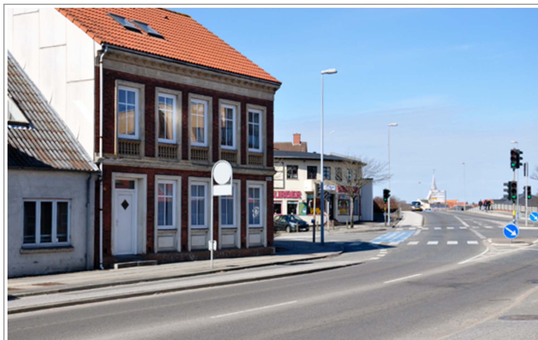
Søndergade nr. 1 med Hotel Platzborg og viadukten i baggrunden.
